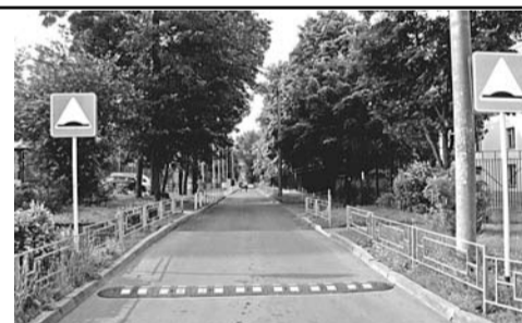
Искусственная дорожная неровность, корп. 830
